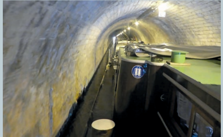
02.08.2019 Tunnelfahrt Saint Albin.
