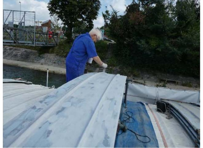
© GB 31.07.2021 Ein entrosteter Lukendeckel wird mit dem Schwingschleifer bearbeitet und mit speziellem grauem Primer grundiert.
